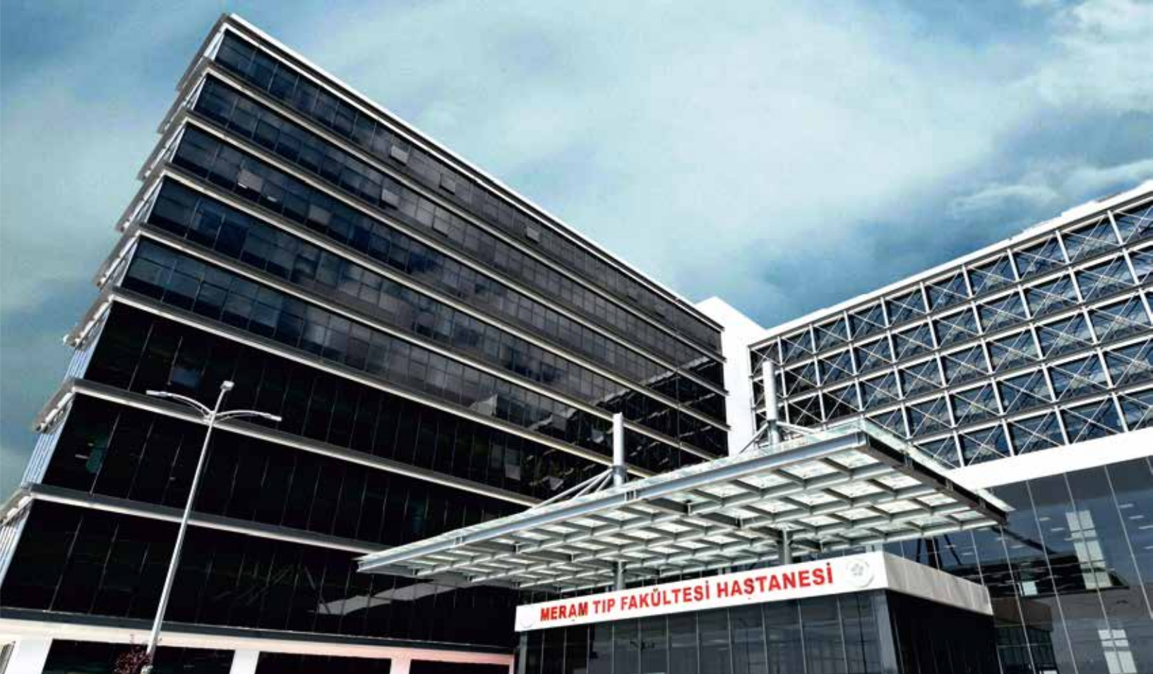
Todos los cuadros eléctricos de BT fueron fabricados por AFB Energy.
